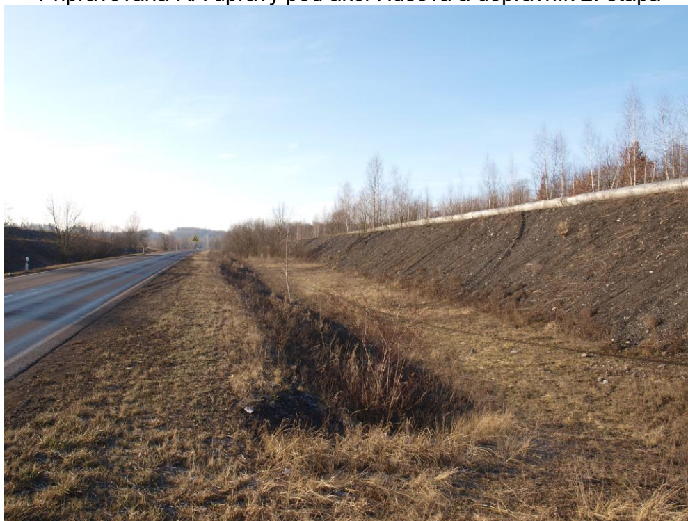
Připravovaná RA úpravy pod akcí Husova a dopravník 2. etapa
