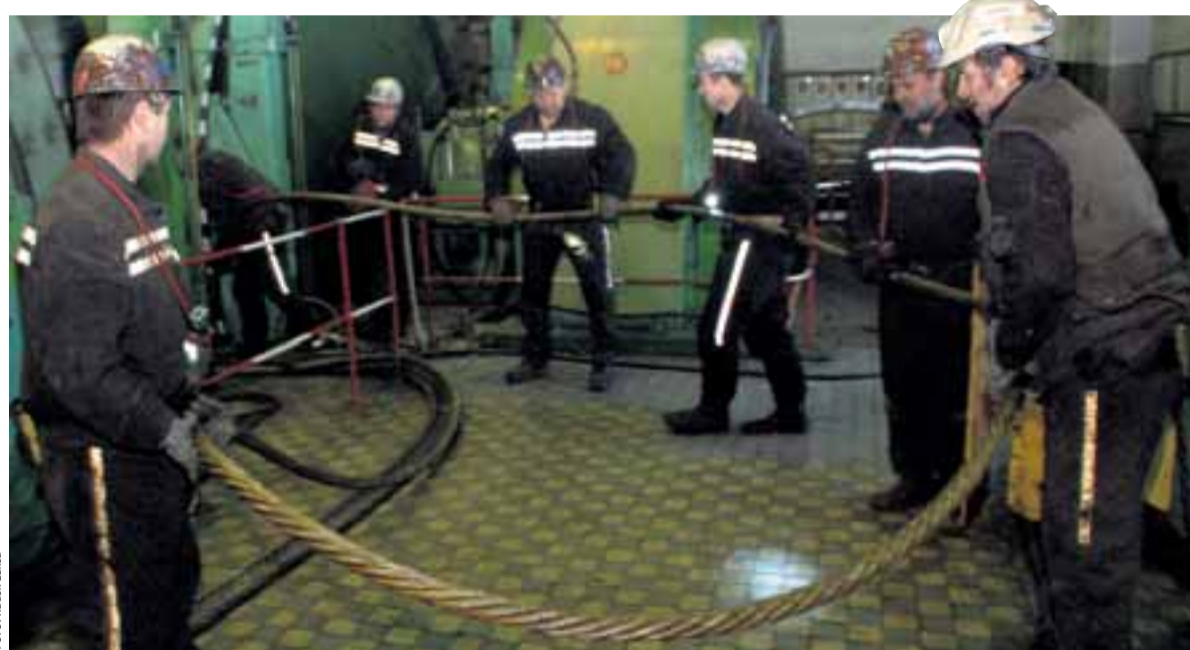
Fyzicky náročné namotávání lana na buben ve strojovně; tady už bylo alespoň tepleji.
