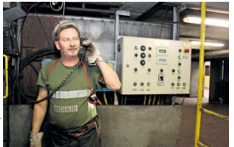
Na nárazi odnímací plošiny sever jámy Mír 5. Narážeč Viliam Kvarda u skříňové návěsního zařízení, která nahradila celou sestavu dřívějších tratových spínačů, prepínačů, zvonků, signálních a svorkovnicových skříní rozmístěných na hlavním stanovišti narážečů a v okolí jámy. Malá, ale chytrá!
