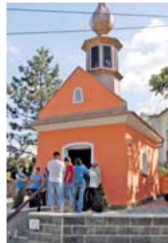
Renovovanou kapličku ve Lhotce...
