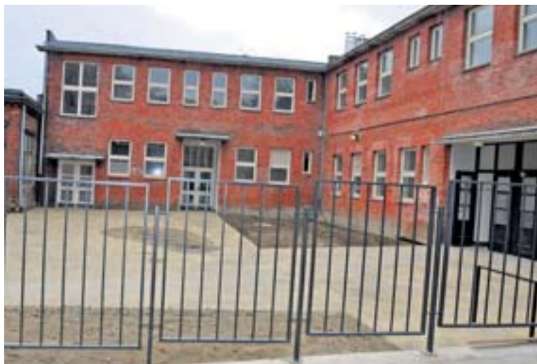
Důl Michal rekonstruoval vstupní budovu.
