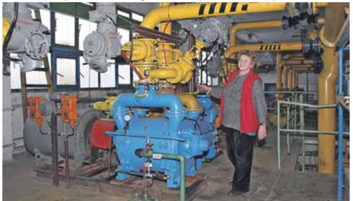
Strojnice Marie Javorková obsluhuje vývěvy a další zařízení v degazační stanici na Staříči.
