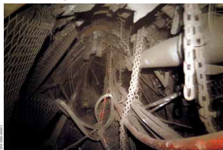
Následky důlního otřesu z 9. září v chodbě 44013 v lokalitě ČSA Důlního závodu 1.
