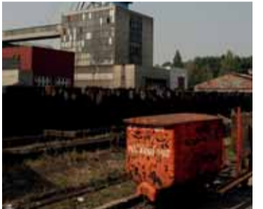
Kolejiště pod chlebovickou těžní věží.
