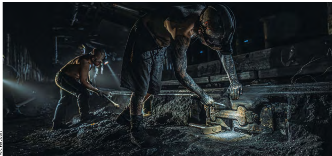
Součástí technické likvidace jsou likvidace důlních zařízení, uzavření všech důlních děl a demolice povrchových objektů.
