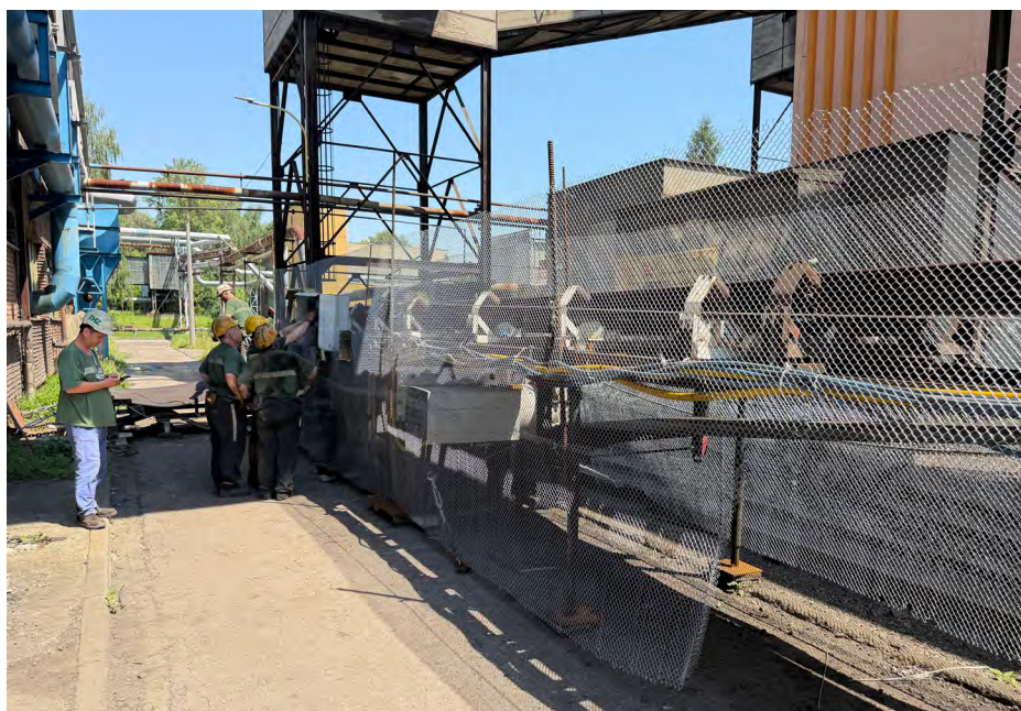
Stavba pásů pro dopravu hlusiny k jámě.
