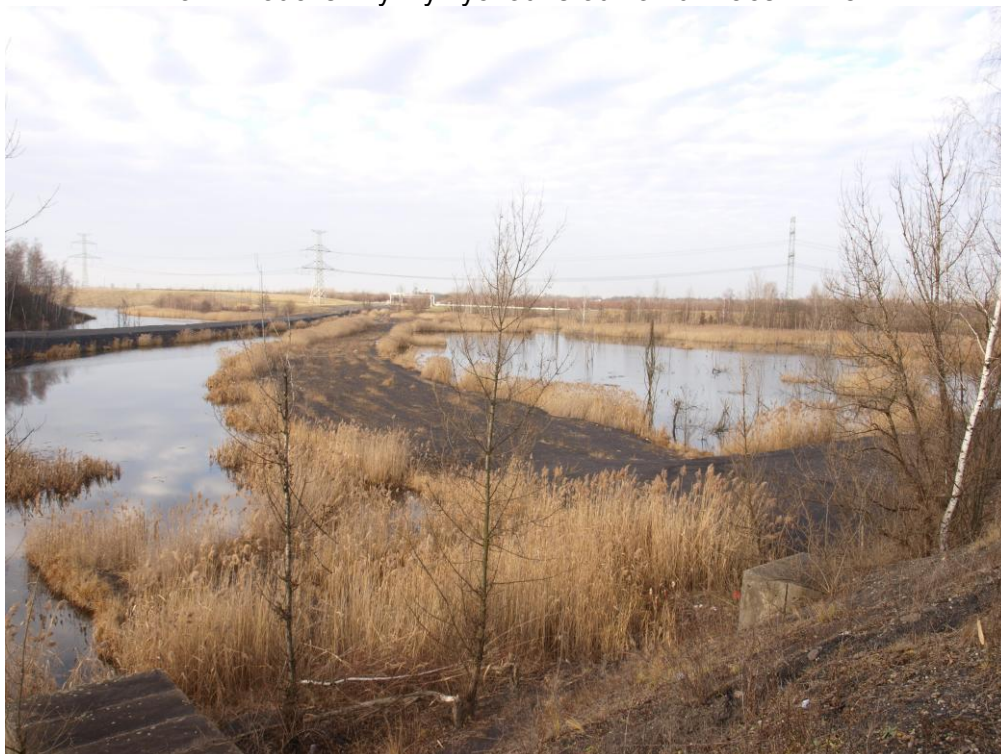
Rozliv Loucké Mlýnky východně od komunikace II/475
