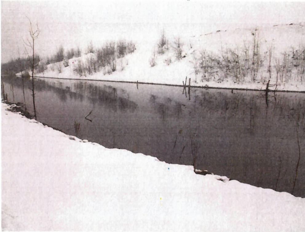
Hráz kalové nádrže „G“
