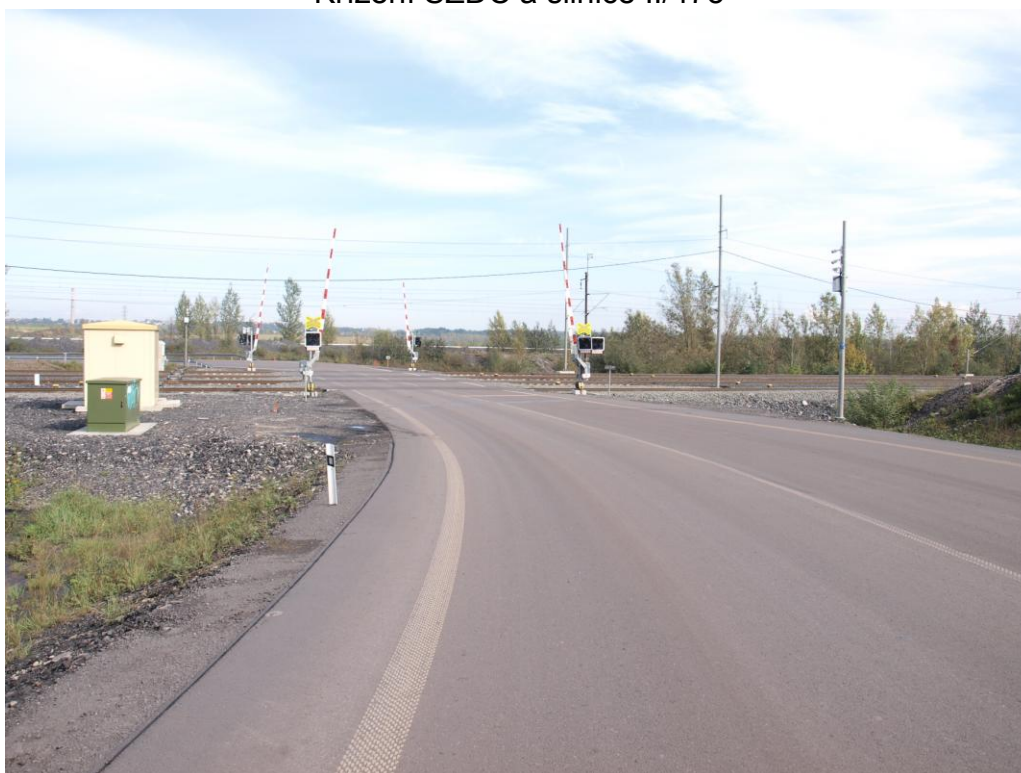
Křížení SŽDC a silnice II/475
