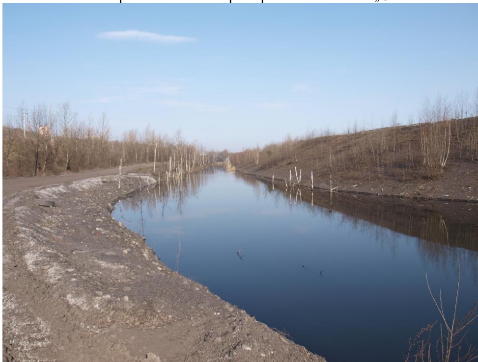
Zátopa v obvodovém příkopu kalové nádrže „G“
