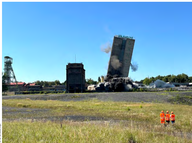
Poslední chvíle lazecké skipové věže.
