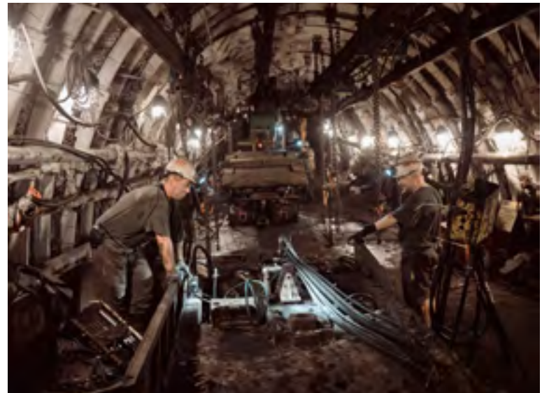
Kompletace výztuže v montážní komoře.
