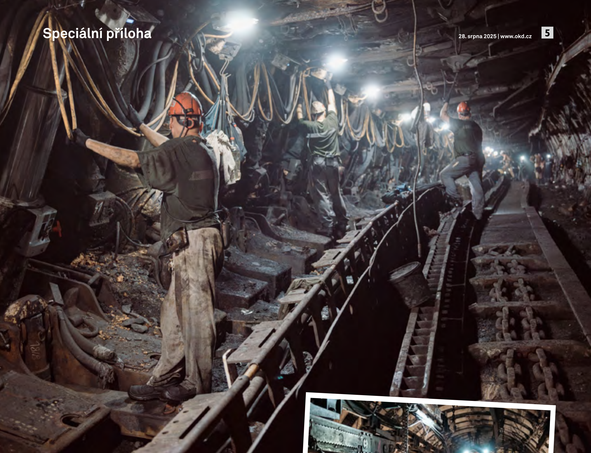
Montáž hydraulických rozvodů v porubu.
