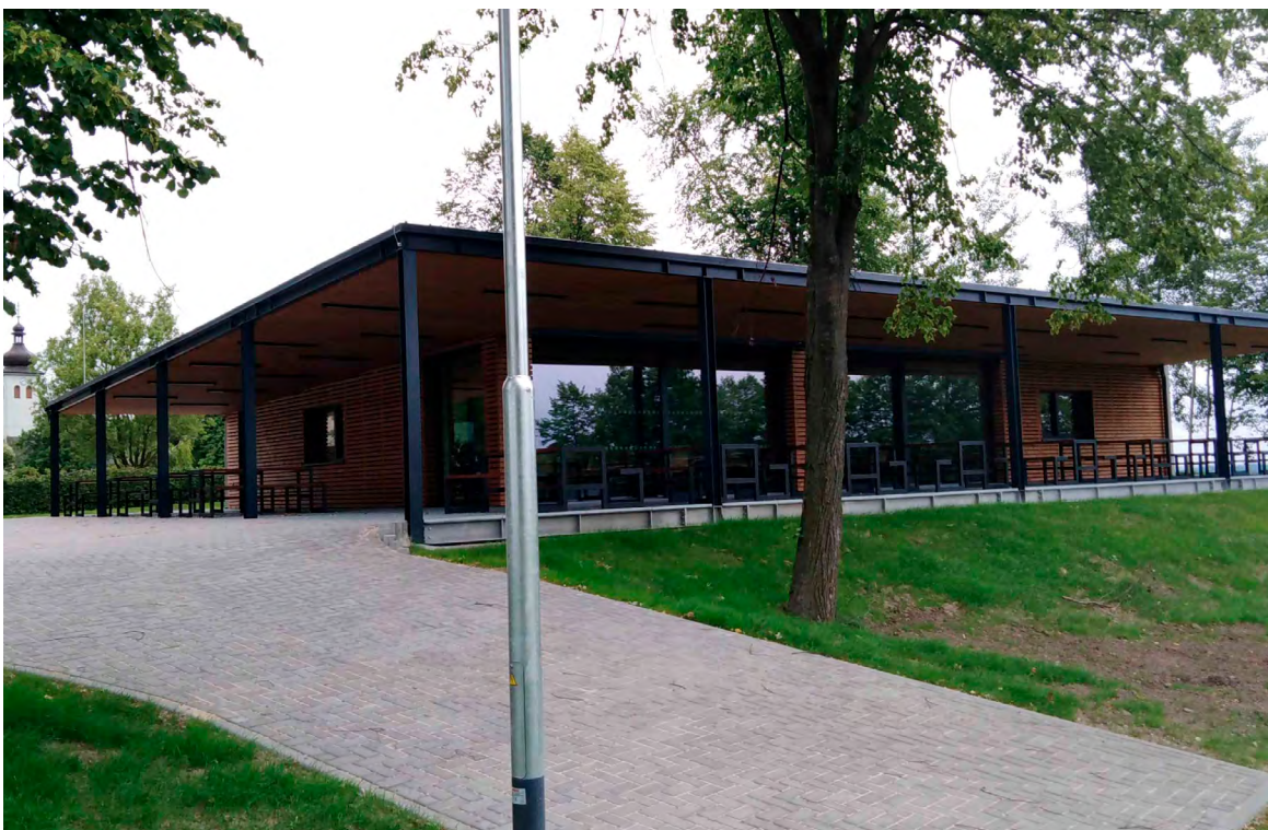
Na výstavbu nového spolkového domu v Soběšovicích přispěla Nadace OKD.
