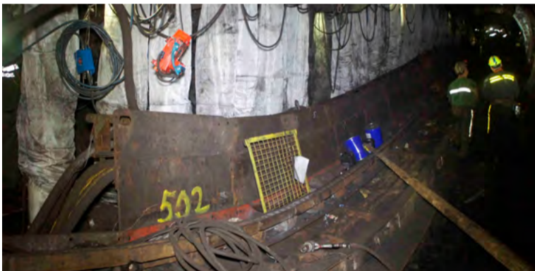
Vybavování nové porubní kapacity.
