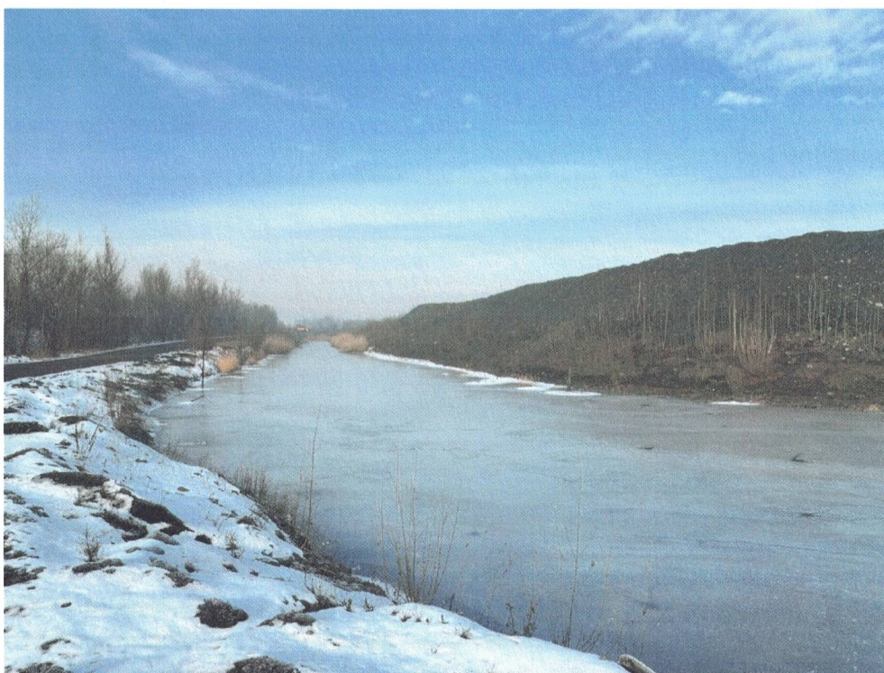
Vodní plocha podél hráze kalové nádrže „G“
