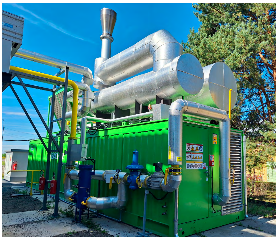
Kogenerační jednotka se připravuje ke zprovoznění.
