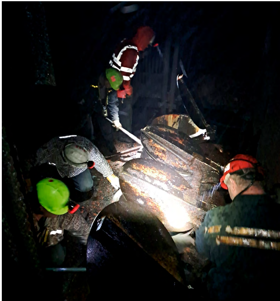
Uzavírání průvětrníků v jámové zátce.
